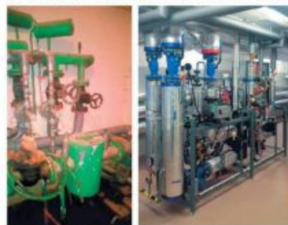
Przykładowy węzeł przed i po modernizacji
